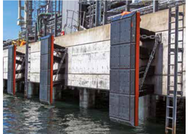
Ethanol Jetty | Stenungsund | Sweden
