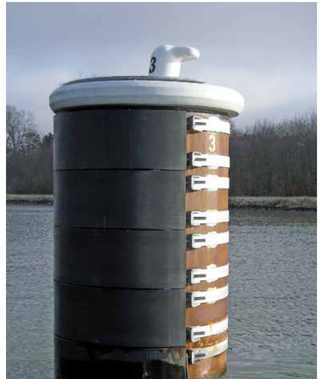
Standby piles | Kiel | Germany
