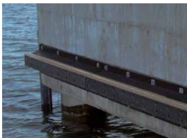
Ethanol Jetty | Stenungsund | Sweden
