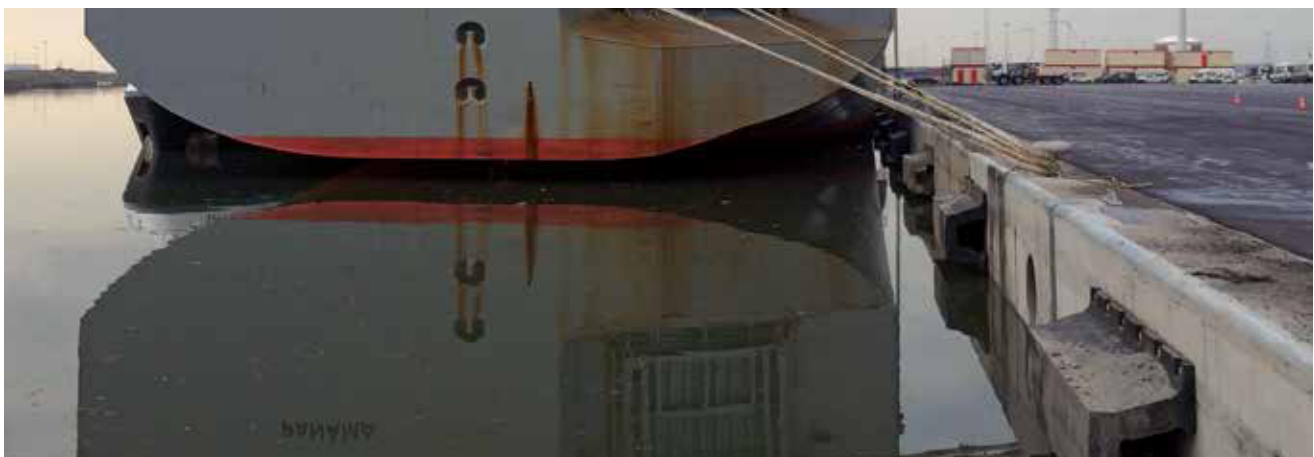
Toyotakaai | Zeebrugge | Belgium
