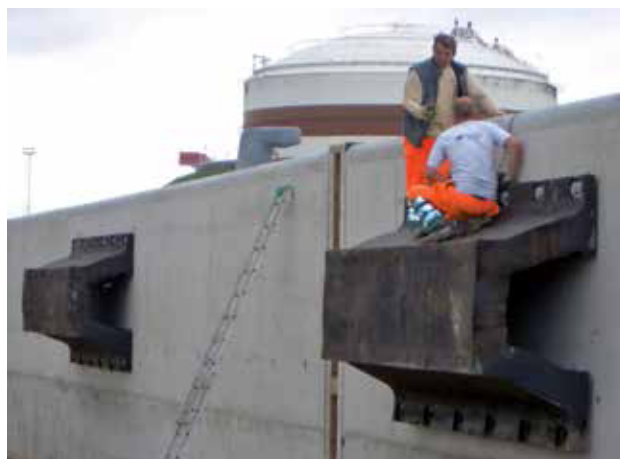
Toyotakaai | Zeebrugge | Belgium
